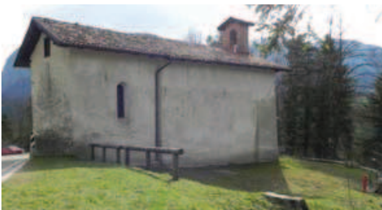
Fig. 2. Chiesa di san Silvestro (veduta da W).
